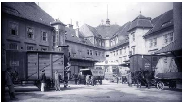
Nádvoří továrny firmy Meinl ve Vídni, kam vedla i vlečka (ÖNB)
